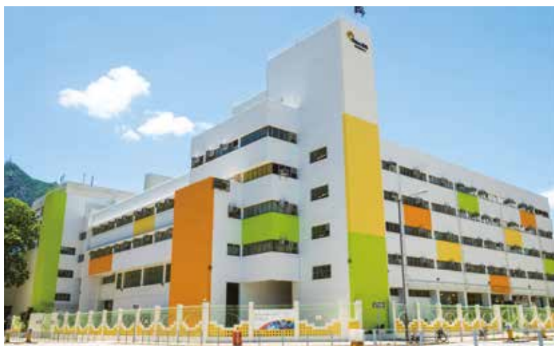
Shine Skills Centre at Tuen Mun 屯門展亮技能發展中心
